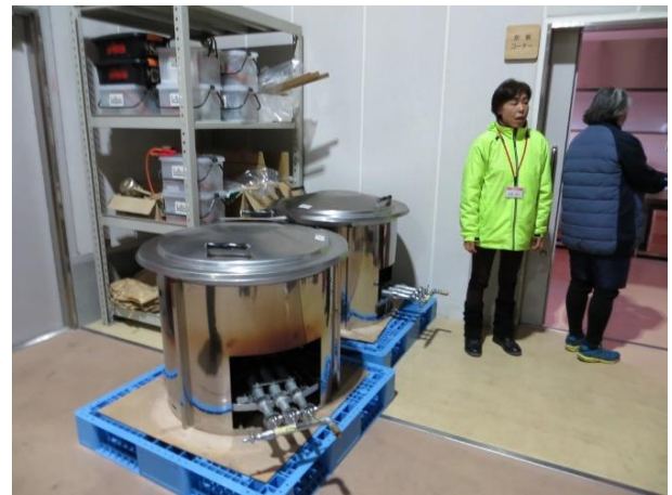
相馬市防災備蓄倉庫（内部）
